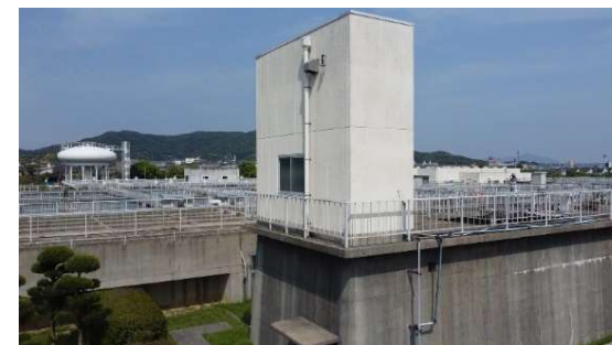
高所の外壁や配管イメージ
