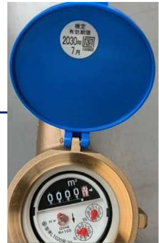
水道メーター
