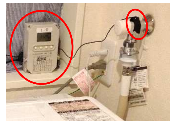
写真 測定機器設置の様子
