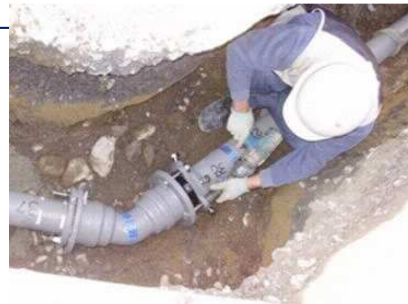
配水支管工事の施工
