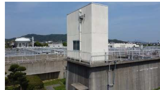
高所の外壁や配管イメージ
