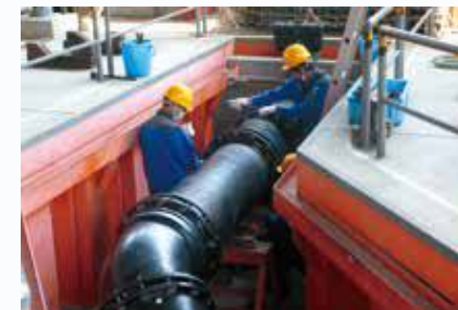
▲配管技術の研修イメージ
