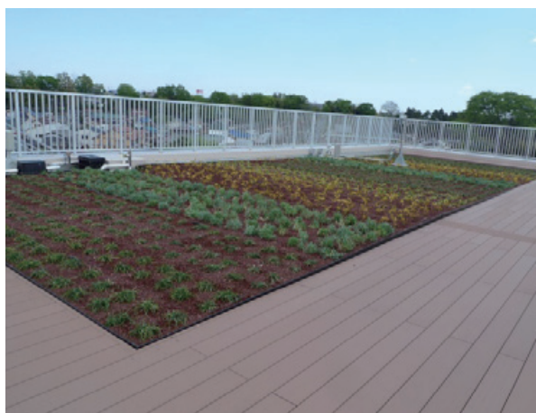
羽村取水管理事務所の屋上緑化
