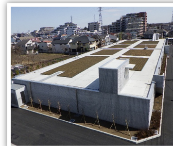
幸町浄水場の屋上緑化
