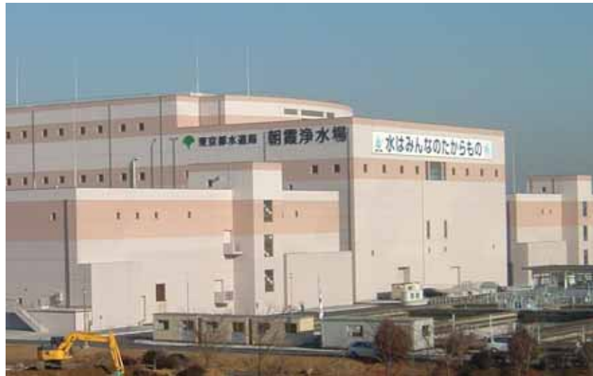
写真 水道施設であることが明確な事例
