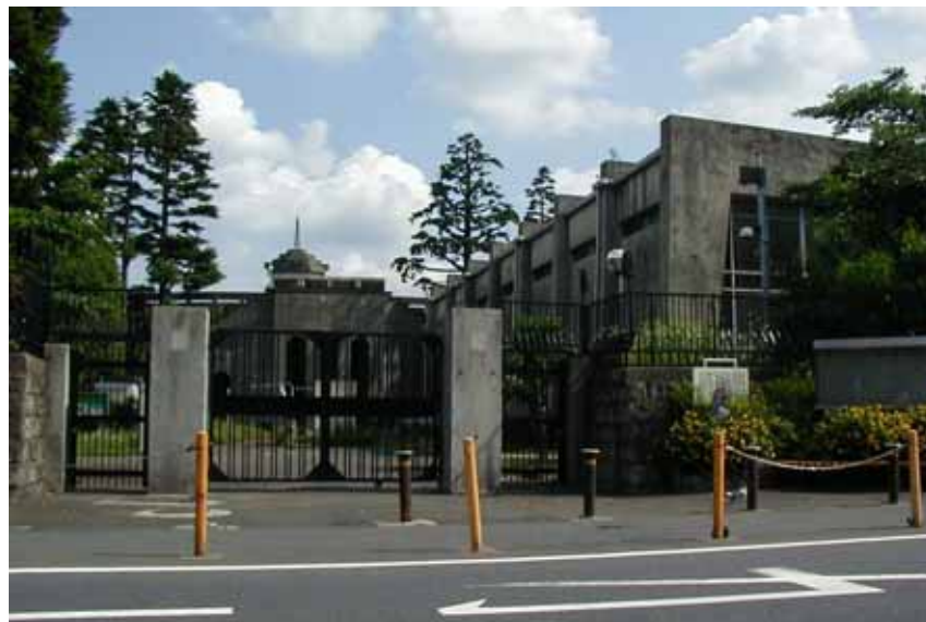
写真 水道施設であることがわかりにくい事例
