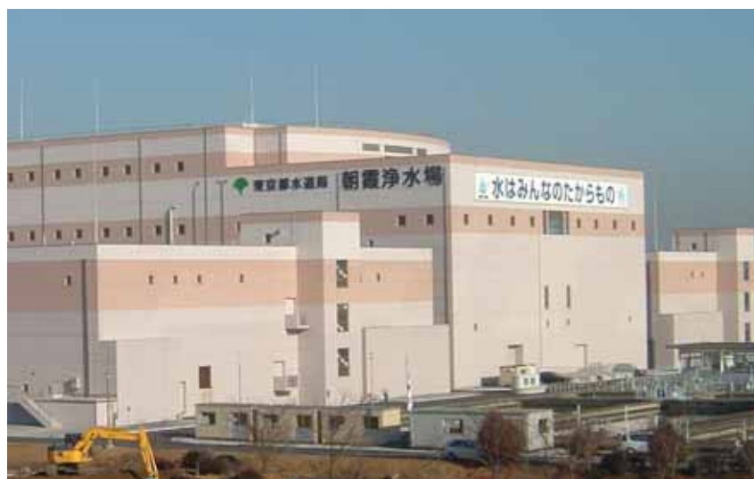
水道施設であることが明確な事例
