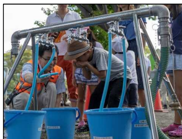
耐震性貯水槽からの応急給水
