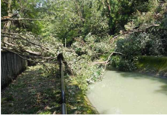
琵琶湖疏水（第1疏水）の被害状況
