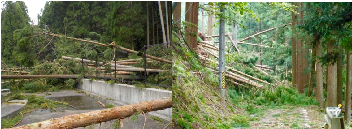
山間地域の被害状況（黒田浄水場）
