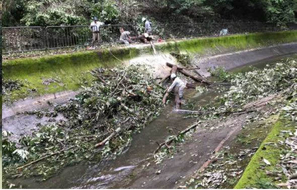
琵琶湖疏水（第1疏水）の倒木撤去作業
