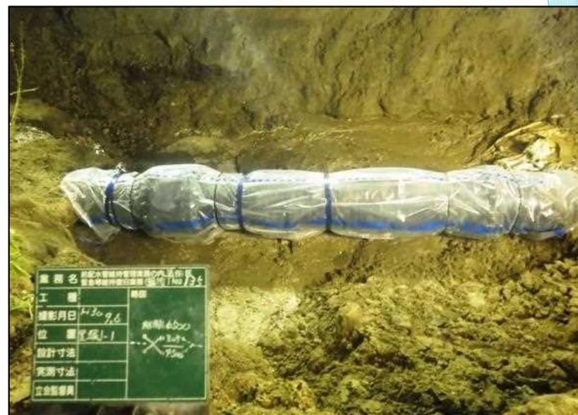
DIP (K形継手 φ500mm) の復旧完了状況
