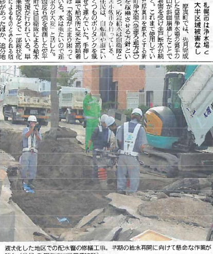
液状化した地区での配水管の修繕工事。早期の給水再開に向けて懸命な作業が続く。(8日、札幌市南岗区里塚地区)
