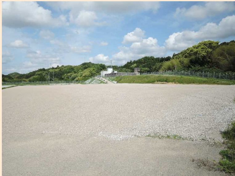
針木浄水場駐車スペース
