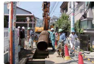
▲古い水道管の取替え
