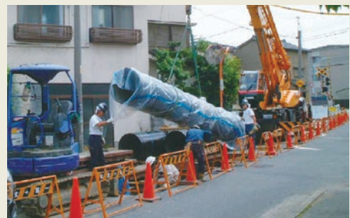
▲ 水道管路の耐震継手化工事
