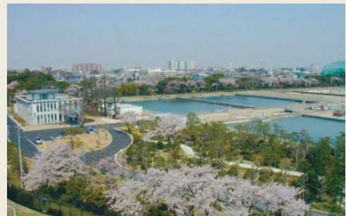
▲ 境浄水場（代替浄水施設を整備予定）
