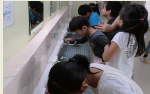
▲ 小中学校の水飲栓直結給水化モデル事業実施校
