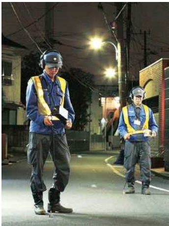
夜間の漏水発見作業
