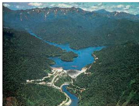
矢木沢ダム（出典：水資源機構）
