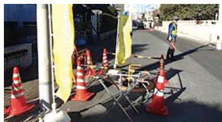
消火栓からの応急給水
