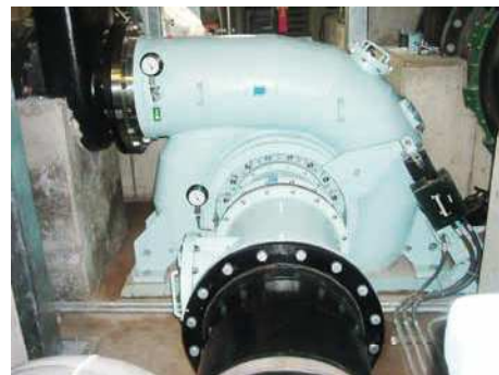
給水所における小水力発電設備
