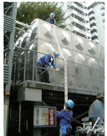
給水車からの高所揚水訓練
