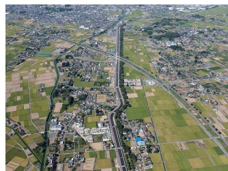
利根川の水を荒川に送る武蔵水路（出典：水資源機構）
