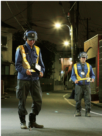
夜間の漏水発見作業
