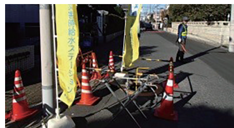
消火栓からの応急給水
