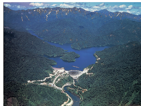
矢木沢ダム（出典：水資源機構）
