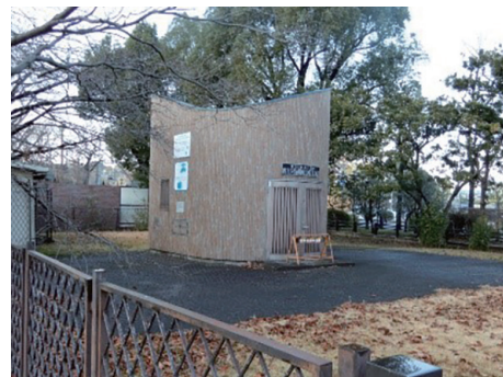
日比谷公園の応急給水槽
