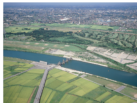
秋ヶ瀬取水堰（出典：水資源機構）
