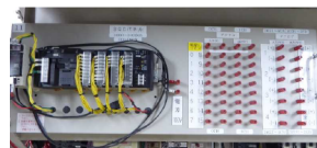
【Fig.10】 Panel example (Sequence Panel)
