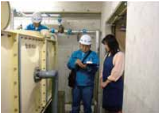
▲貯水槽水道の点検調査（「クリーンアップ！貯水槽」）
