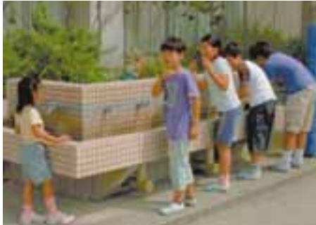
▲水飲栓が直結給水化されている 大田区立 道塚小学校
