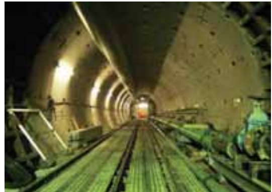
▲東南幹線シールド工事※
