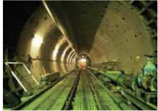
▲東南幹線シールド工事※
