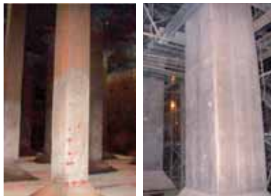
▲配水池耐震化工事（柱を太くして補強）
