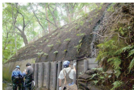
▲木柵工等による法面補修
