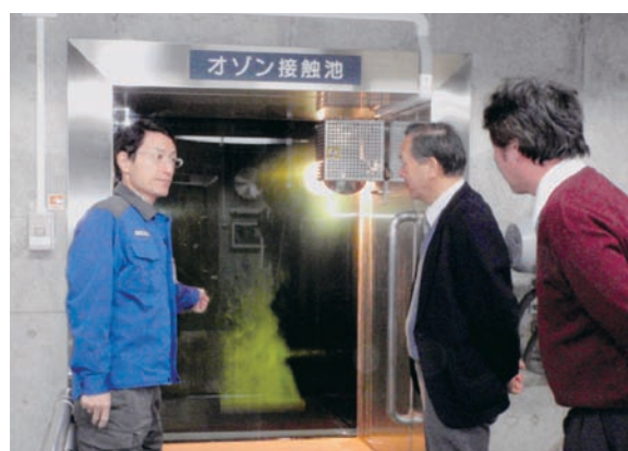
▲施設の内部を見学できる窓（朝霞浄水場）
