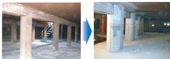
▲沈でん池の耐震強化（長沢浄水場）
