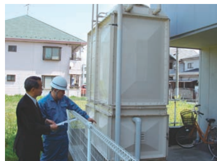
▲直結切替え見積りサービス (現地調査)
