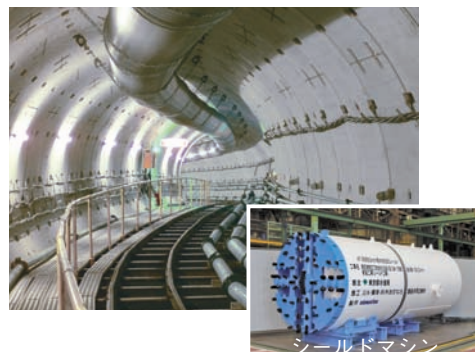
▲東南幹線シールド工事※
