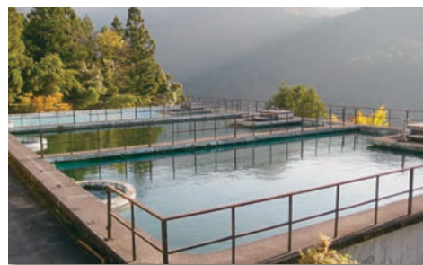
▲山間部にある奥多摩町の浄水場 (氷川浄水場)
