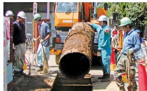
▲水道管路の耐震継手化
