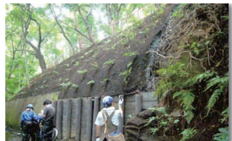
▲木柵工等による法面補修（玉川上水）
