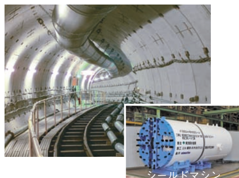
▲東南幹線シールド工事※
