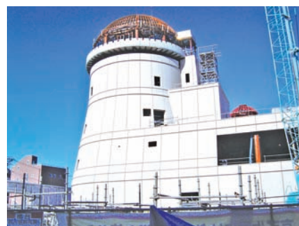
▲大谷口給水所（施工中）
