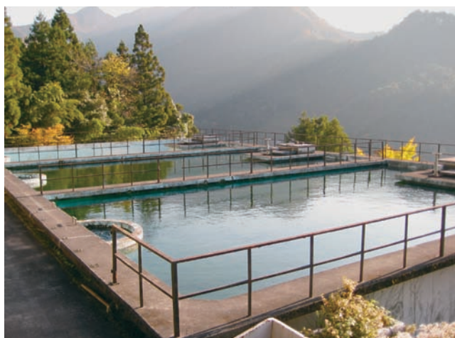
▲山間部にある奥多摩町の浄水場（氷川浄水場）
