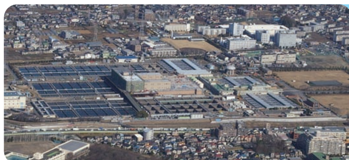
東村山浄水場
