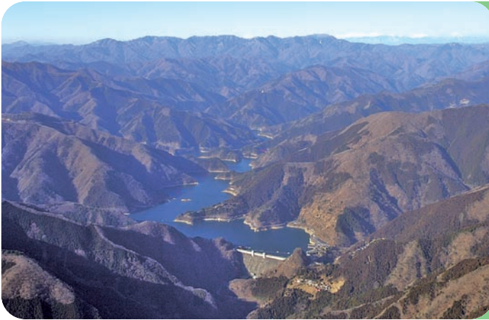
小河内貯水池
