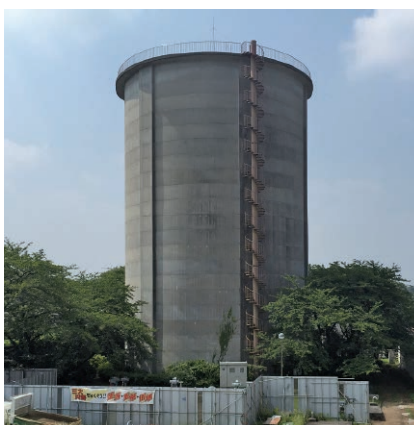
▲老朽化により拡充整備中の深大寺浄水所 (撤去予定の配水塔)
