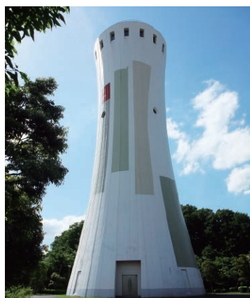
▲多摩丘陵幹線で水が供給される 鑑水小山給水所（高架水槽）
