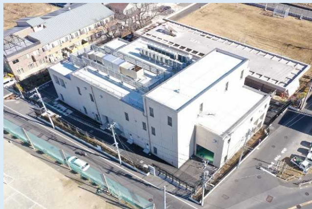
▲ 省エネ型ポンプ設備（美住増圧ポンプ所） 令和4年度に完成した美住増圧ポンプ所では、省エネ型ポンプ設備を導入しました。
