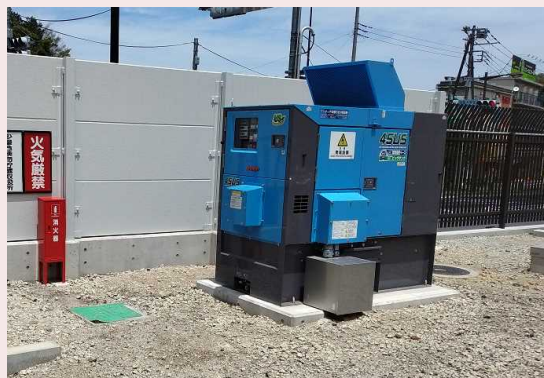
▲程久保増圧ポンプ所(非常用発電設備) 非常用発電設備を整備しました。
