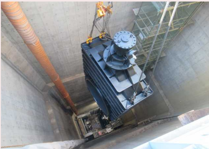
▲制水弁の吊り下ろし状況 第二朝霞上井草線(仮称)では、トンネル内の配管工事を実施しました。
