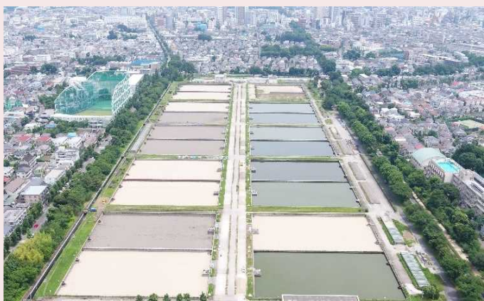
▲工事着手前の境浄水場
