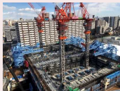
▲ 王子給水所(仮称) 配水池建造状況
