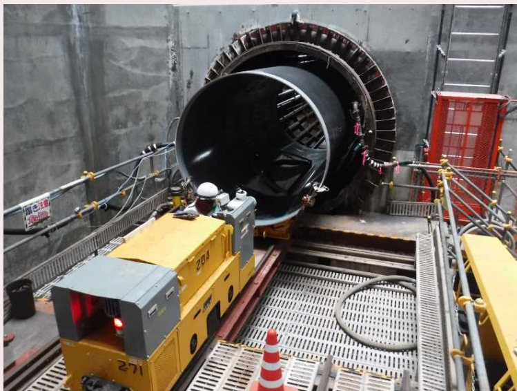
▲導水管布設工事における管の運搬状況(東村山境線(仮称)) トンネル内配管等の工事を実施しました。
