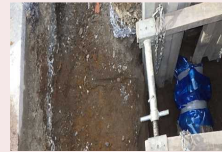
▲給水管撤去後
