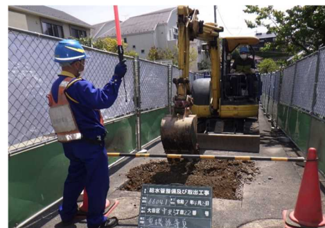
○防音シート付きネットフェンスにて作業エリアを隔離
