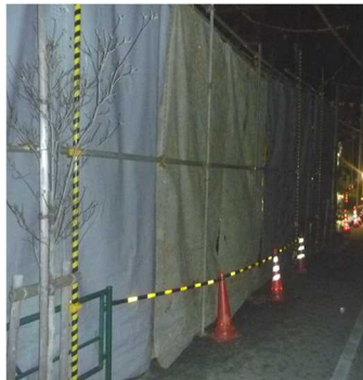
○施工時に防音シートを設置
