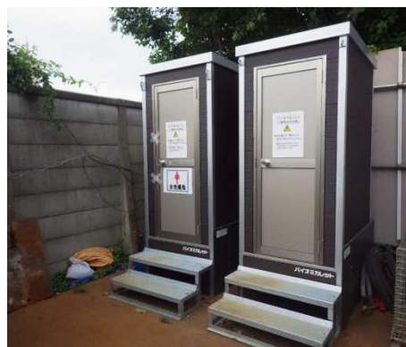
○微生物の力で排泄物を分解するバイオトイレを設置
