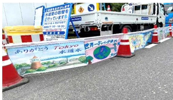
○「水道週間コンクール」受賞作品を現場内に 掲示
