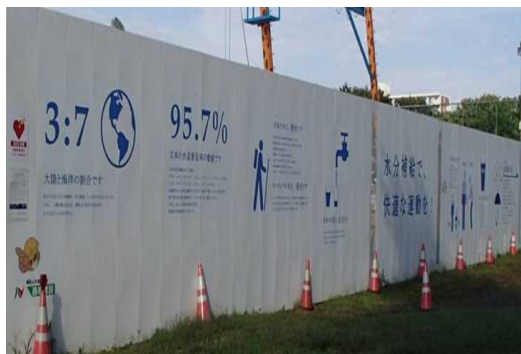
○仮囲いに、水に関する知識や水分補給の 大切さを掲示
