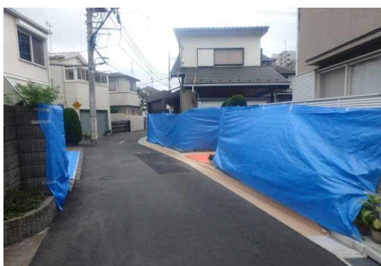
○現場周辺をビニールシートで養生
