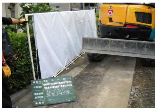
○移動が容易な「熱枯れ防護柵」を設置
