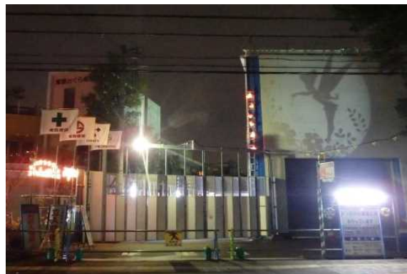
○防音ハウス壁面へプロジェクションマッピング投影
