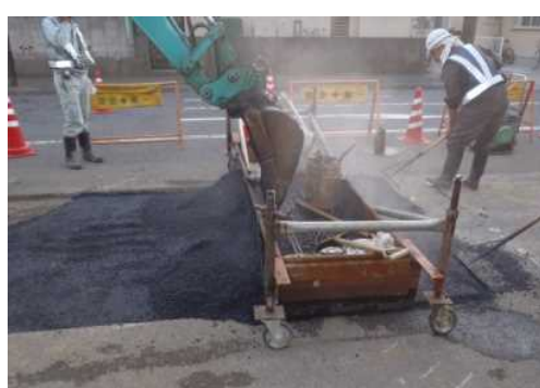
○独自の敷均し用の機材を製作し、舗装工事の時間短縮
