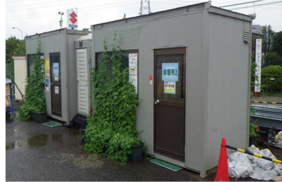
○窓辺にゴーヤカーテンを設置
