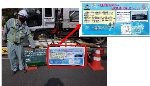
○取り外し可能で安全なターボリン製の 工事内容表示板を設置
