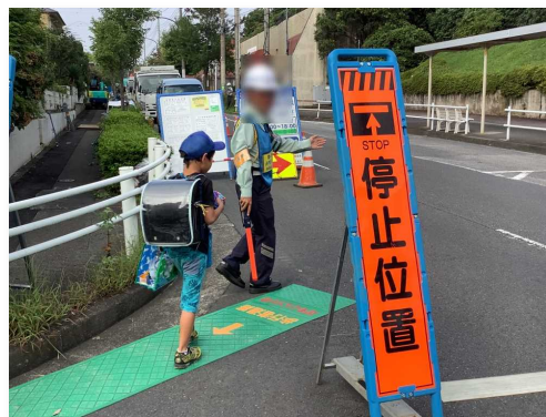
○小学生を誘導するため「通学路みまもり隊」チョッキを着用した専任の誘導員を配置
