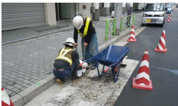
○工事期間中、継続的に雨水集水ますの清掃を実施
