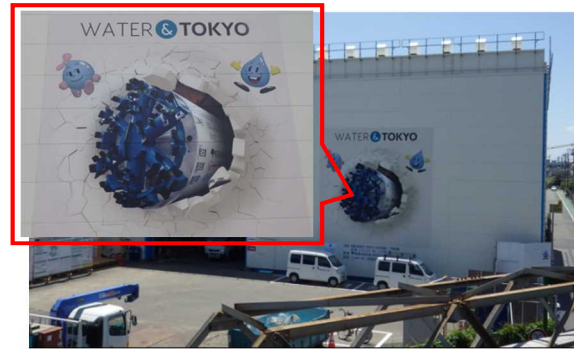
○シールド到達イメージをトリックアートで 立坑壁面に掲示
