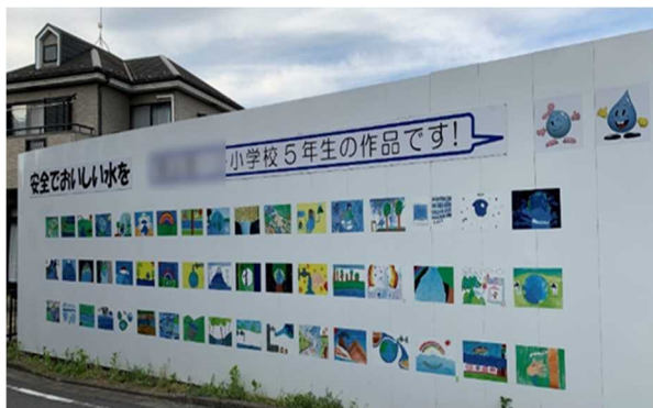
○近隣の小学生が描いた水に関する絵を現場沿道に掲示してPR
