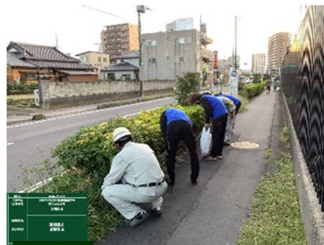
○工事現場周辺の清掃を実施
