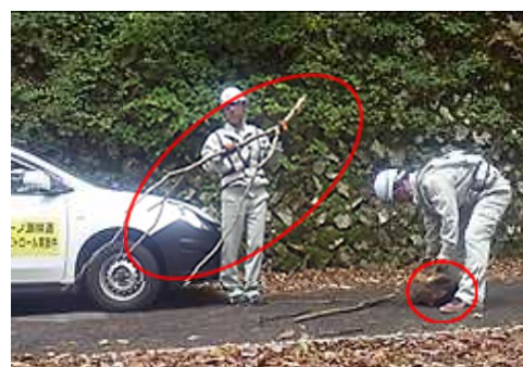
○林道にて倒木・転石の撤去作業
