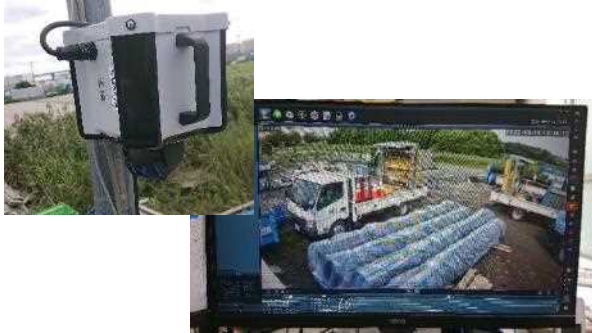
○資材置き場に防犯カメラ設置
