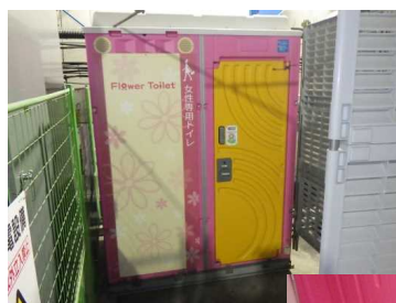
○微生物の力で排泄物を分解するバイオトイレを設置
