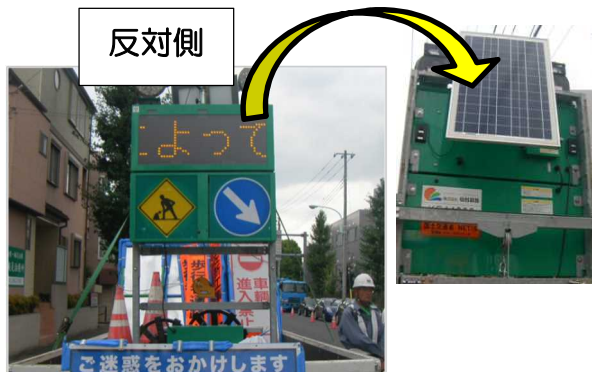
○ソーラー式工事標示板の活用
