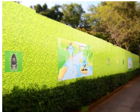
○周辺環境と調和するために緑の仮囲いを設置
