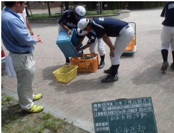
○隣接する中学校から工事現場に入ってしまったボールを回収・返却
