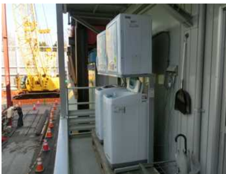
○洗濯機・乾燥機の設置
