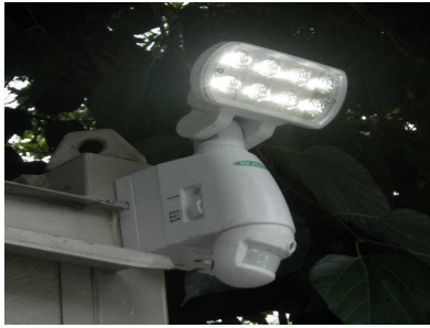
○材料置場、出入口にセンサーライトの設置
