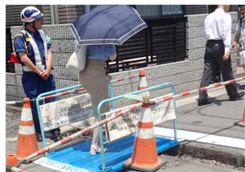
○安全通路（鋼製栈橋）の設置
