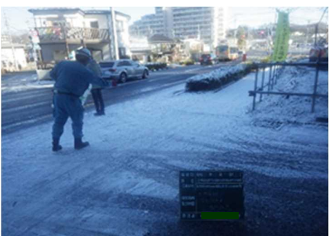
○路面凍結防止のため、凍結防止剤散布
