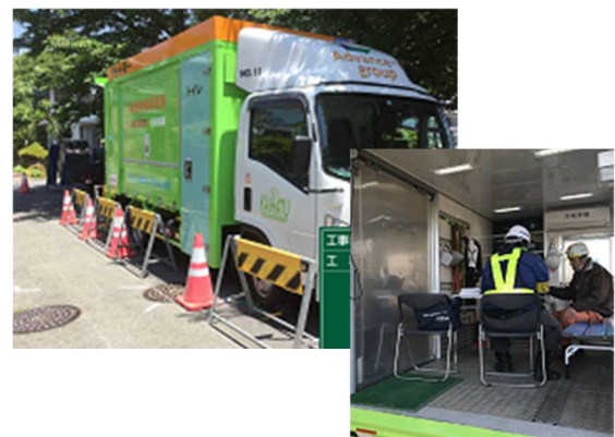
○移動式現場事務所の設置
