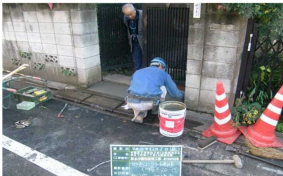
○余った材料でお客さま宅玄関先のコンクリートを補修
