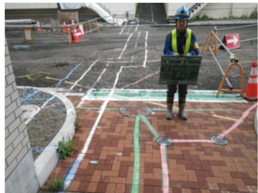
○埋設物設置場所をマーキングし掘削事故防止
