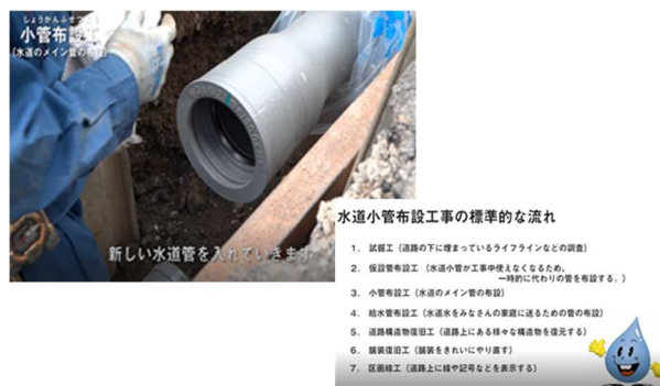
○水道工事の流れがわかる DVD を作成し、小学校に配布して PR
