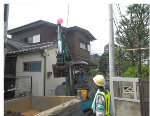
○事故防止への工夫に、バックホウの最も高くなる位置にボールを設置し誘導
