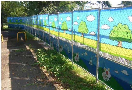
○周囲になじみやすいB型フェンスの設置
