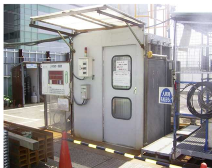
○立坑内用のエレベータを設置し工事見学者にも利用
