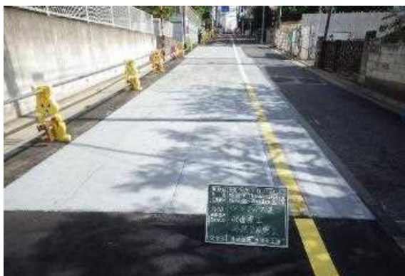
○覆工板に遮熱性舗装を塗布し路面温度を 低減
