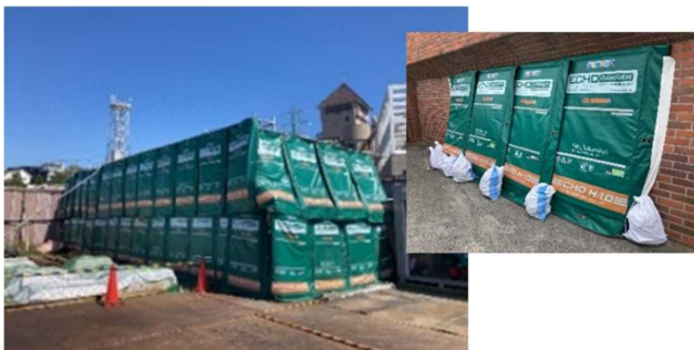
○コンプレッサー周囲及び作業箇所に防音マッ トを設置
