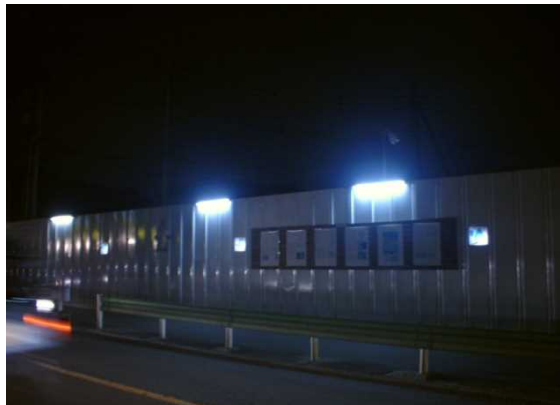
○仮囲いに照明を設置
