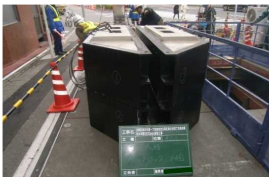
○推進用支圧壁にプレキャストを採用し、騒音振動を低減
