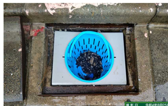
○雨水枳への土砂流入防止対策を実施
