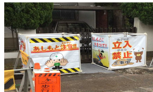
○オリジナル防護柵の設置
