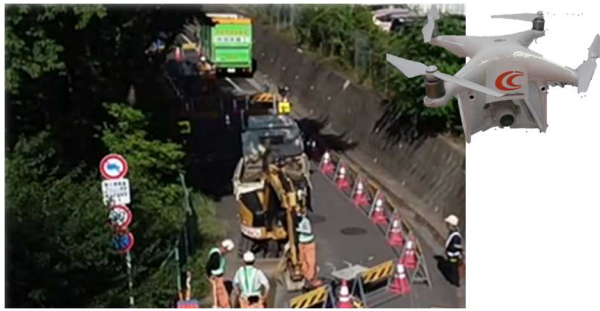
○ドローンによる現場管理 (ドローンの使用に当たっては、航空法や条例等による規制を確認の上、使用すること)
