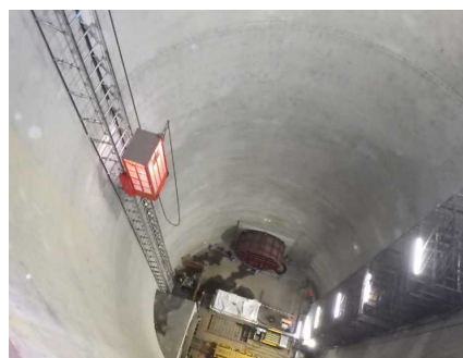
○立坑内用のエレベータを設置し工事見学者にも利用
