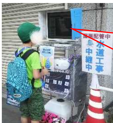
○工事映像のライブ放映
