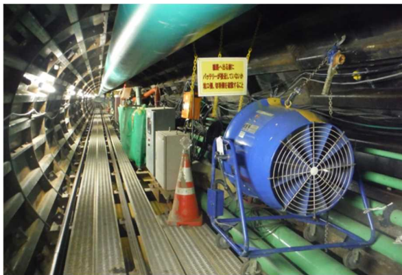
○トンネル内に送風機を設置
