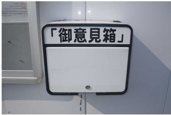
○仮囲いに御意見箱を設置
