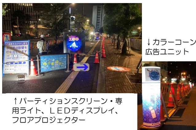
○通行者の視認性向上を図るため、工夫を凝らした誘導で安全対策
