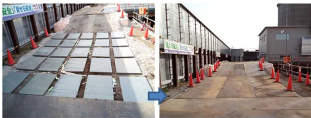
○衝撃・振動抑制のため、防振マットを設置
