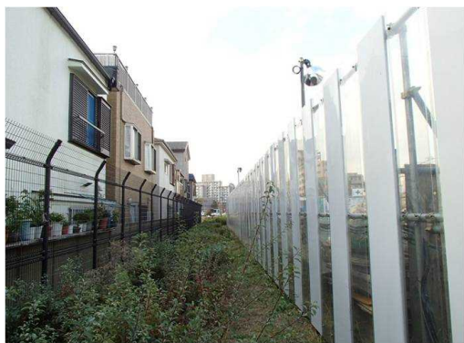
○圧迫感のない透明な仮囲いを設置
