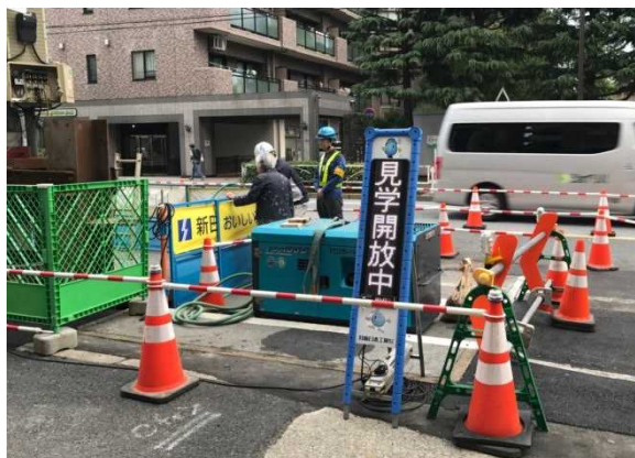
○現場見学エリアの設置
