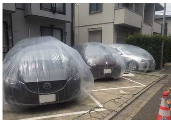
○工事現場周辺の自動車に保護カバーを設置
