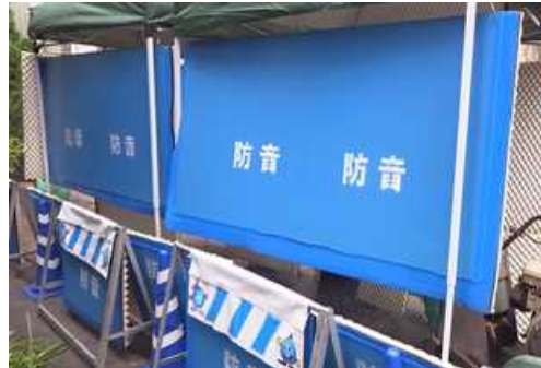
○舗装切断時に防音パネルを設置
