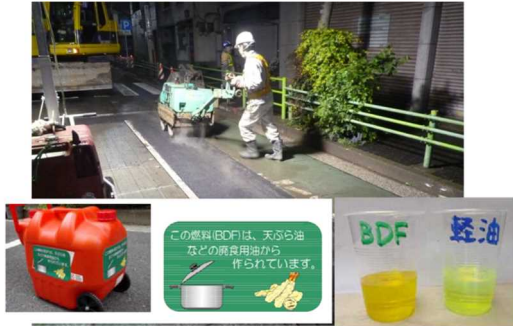
○小型施工機械の燃料に BDF 燃料を使用
