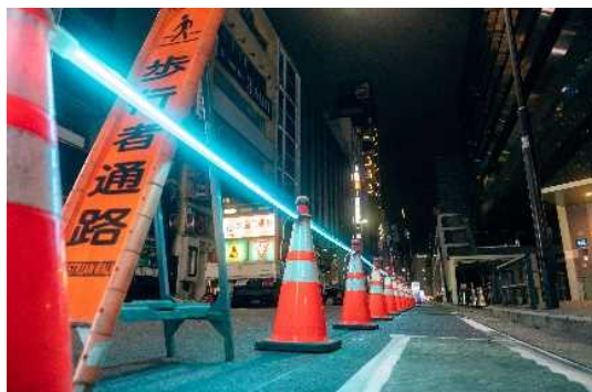
○光るコーンバーを作業帯に設置
