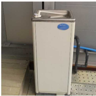
○冷水器の設置
