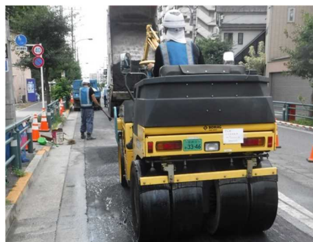
○仮舗装転圧時にローラーを使用し、騒音低減
