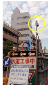
○常設作業帯へ防犯カメラの設置
