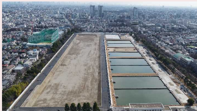
▲工事中の境浄水場 既存施設の撤去工事が完了しました。
