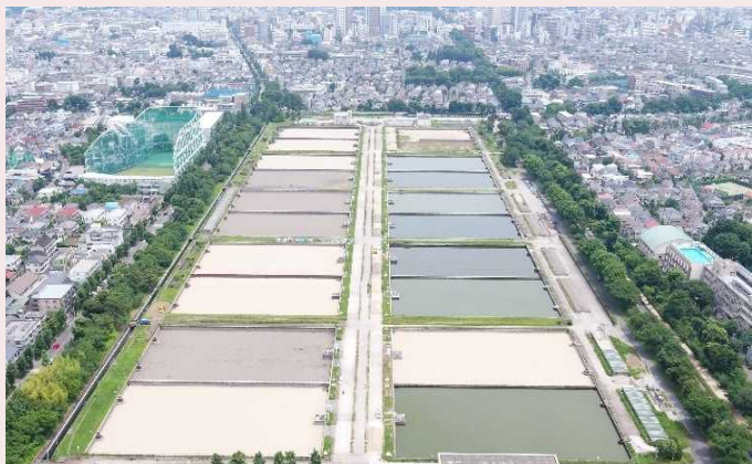
▲工事着手前の境浄水場
