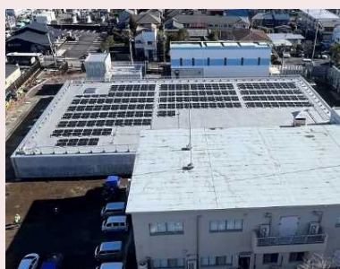
▲ 深大寺給水所 配水池築造状況
