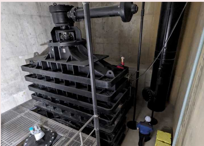
▲制水弁の据付状況 第二朝霞上井草線は、令和5年度に整備が完了し、運用を開始しました。
