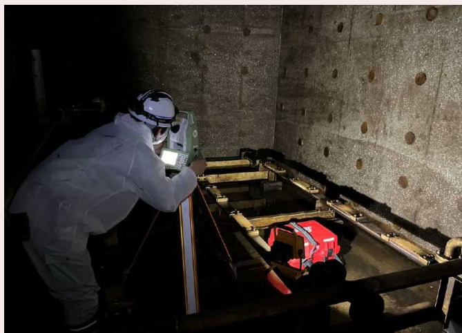
▲ひび割れ等の損傷状況についての調査
