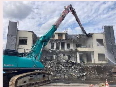
▲ 柴崎給水所 既存施設撤去状況
