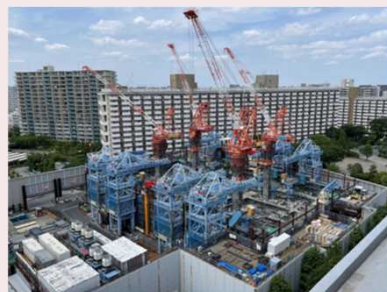
▲ 王子給水所(仮称) 配水池築造状況
