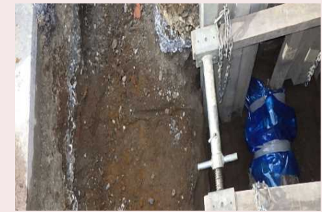
▲給水管撤去後
