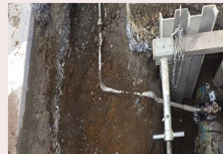
▲給水管撤去前
