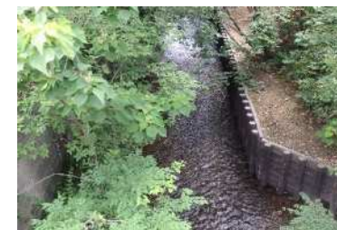
▲法面保護工事の実施 (玉川上水)
