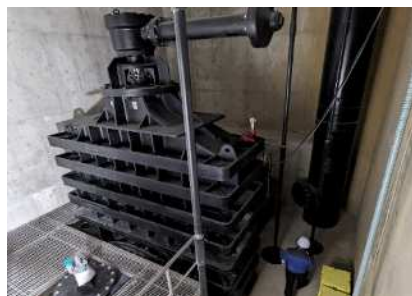
▲第二朝霞上井草線の制水弁の据付状況
