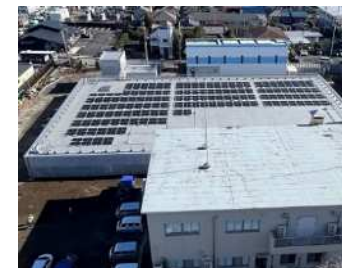
▲深大寺給水所 配水池築造状況
