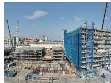
▲和田堀給水所 配水池及びポンプ棟築造状況
