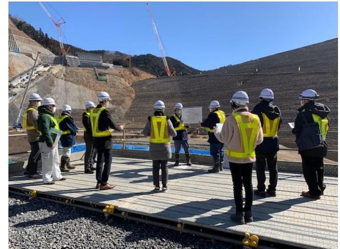
建設中の南摩ダム堤体付近にて説明を受ける様子
