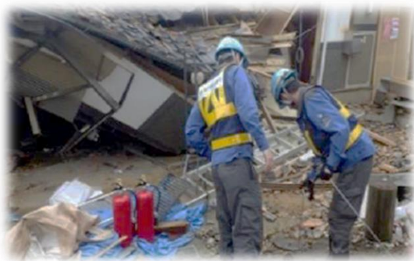
▲応急復旧現場での漏水調査の様子（熊本県益城町）
