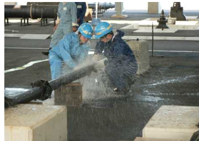
図18 漏水防止技術研修の様子
