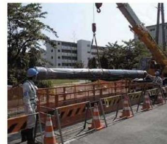
水道管路の取替工事の様子
