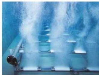
▲オゾン接触池 オゾンを含んだ空気を、水に吹き込んで接触させます。
