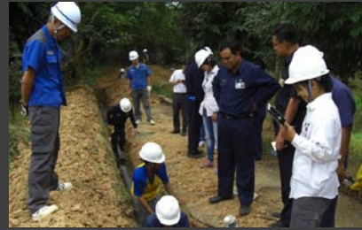
▲ミャンマーでのインフラ整備事業(水道管取替作業)
