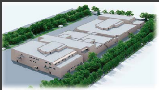
高度経済成長期に整備した 大規模浄水場の更新
