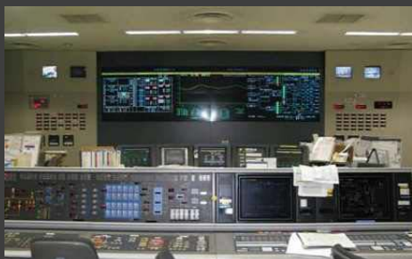
膨大な設備機器の計画的な更新
