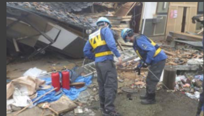
▲ 被災地での応急復旧(熊本地震)
