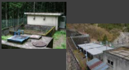
多摩地区の小規模浄水所の再構築
