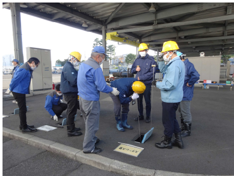
音聴棒を使った漏水調査
