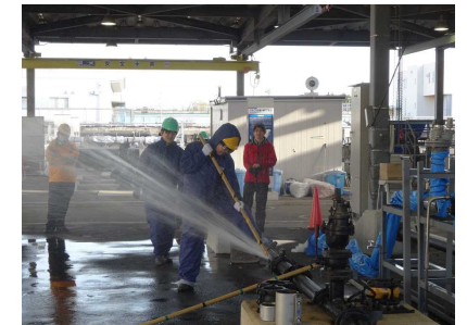
木栓を使った漏水修理
