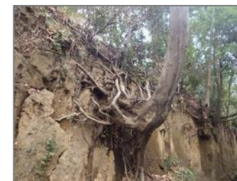
直壁法面に生育(a)
