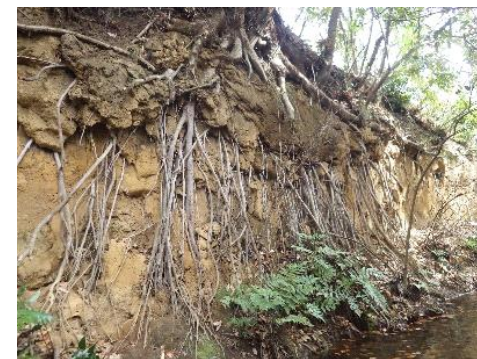
(根系発達による崩落)
