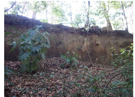
オーバーハング状法面
