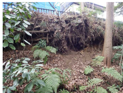
②深い表層崩落
