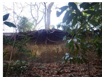
②深い表層崩落
