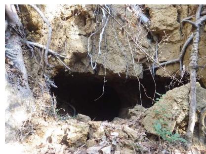
②深い表層崩落
