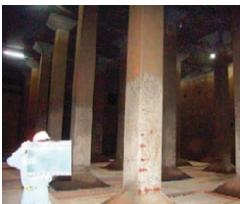
配水池耐震化施工前
