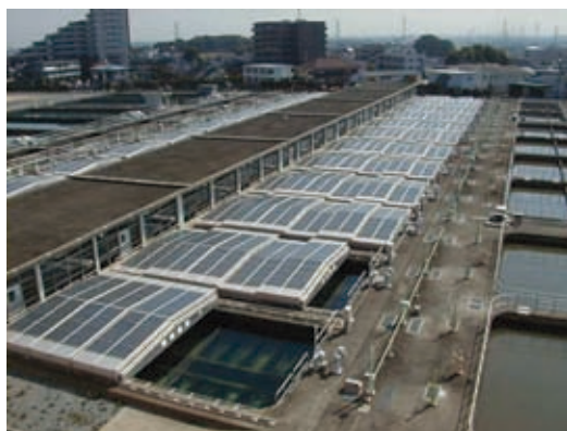
ろ過池の覆がい化（朝霞浄水場）
