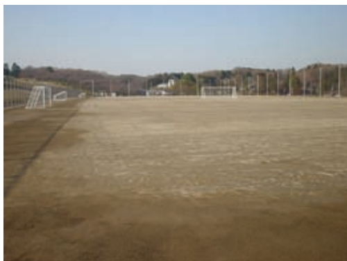
浄水場発生土の有効利用例 (グラウンド舗装材への適用)
