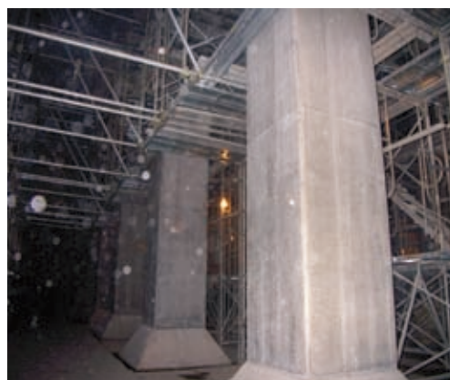
配水池耐震化施工中 (柱を補強)
