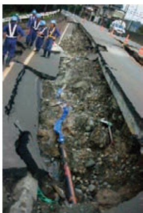
新潟県中越地震復旧作業
