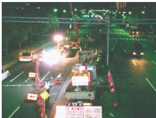
昼夜を問わない都市機能の維持 (配水本管布設工事)
