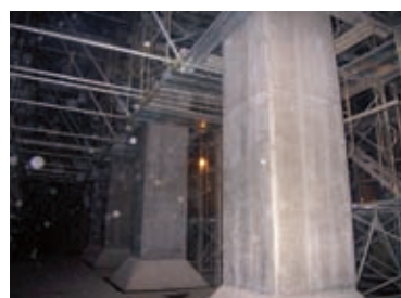
配水池耐震化施工中（柱を補強）
