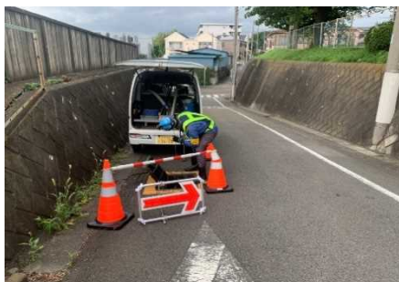
漏水調査訓練（東京水道（株））
