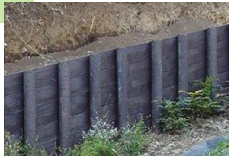
擬木柵（施工例）
