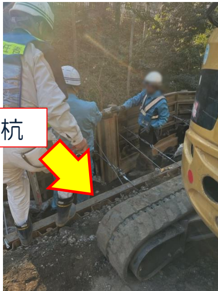
【控え杭の打設・ワイヤー固定】
