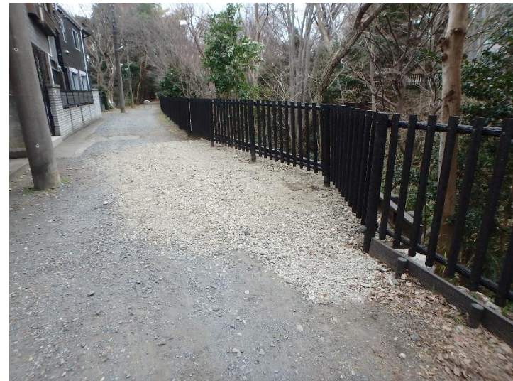
【応急復旧工事完了（令和5年2月末）】
