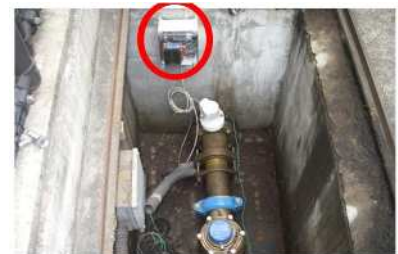
遠隔水圧計測装置を量水器付近に設置した例
