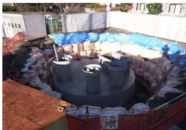
〔静岡市の事例（縦型）※工事中〕
