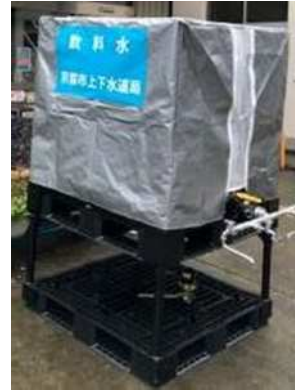
〔京都市の仮設水槽〕
