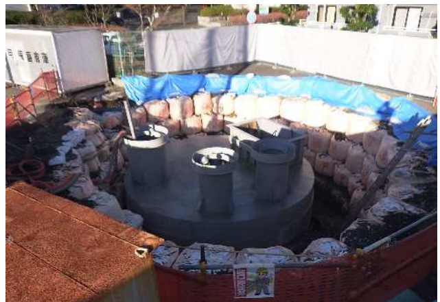
〔静岡市の事例 (縦型) ※工事中〕
