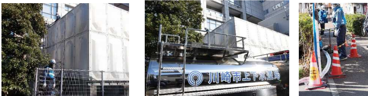
〔合同訓練事例（左、中：給水車から受水槽への給水、右：消火栓等からの給水）〕
