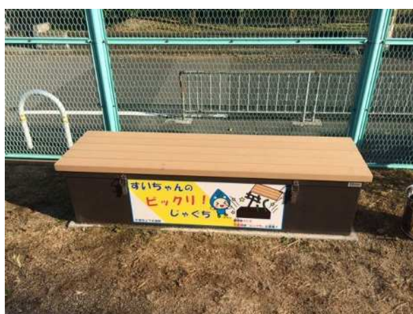
〔堺市の事例（左：給水栓使用時、右：収納時ベンチとして利用）〕
