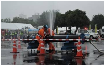
〈応急復旧訓練〉
