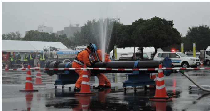
〈漏水を修繕する応急復旧訓練〉
