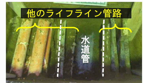
埋設物が輻輳している例
