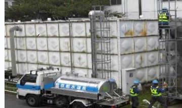
〈給水車による応急給水〉
