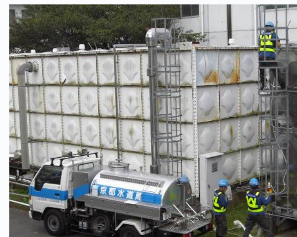
〈給水車から医療機関への応急給水〉
