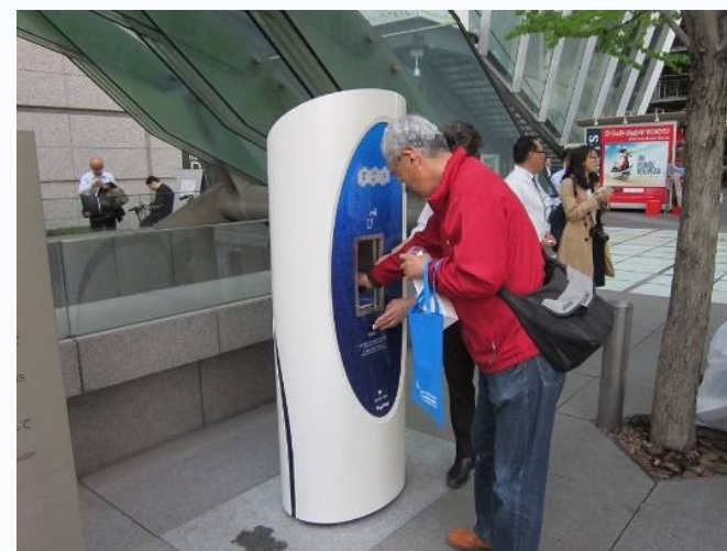
屋外型のボトルディスペンサー式水飲栓 (東京国際フォーラム)
