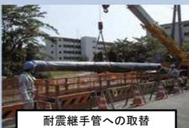
耐震継手管への取替
