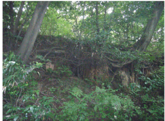
＜松影橋下流側＞
